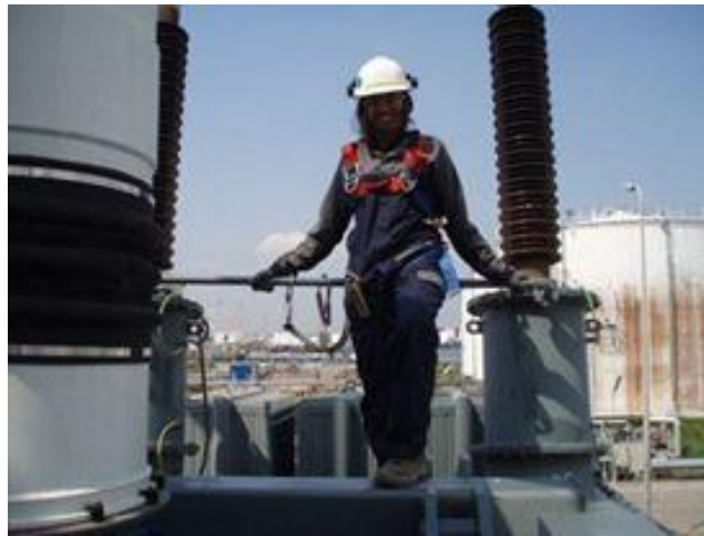
Geetanjali sur un transformateur haute tension à Pernis, aux Pays-Bas
